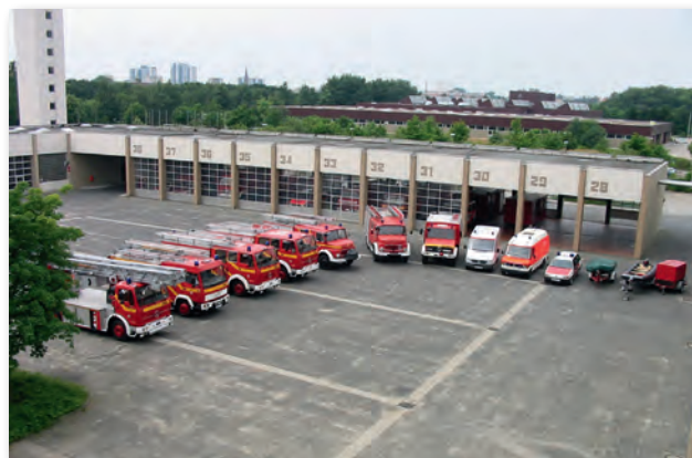
Abb. 24 Fahrzeugpark der Landesfeuerweherschule Bremen in Bremerhaven
