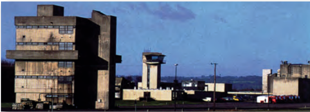
Abb. 5 Ein Teil des Bereiches des Feuerwehr-Ausbildungsgeländes in der neuen Feuerwehr-Fachhochschule 1974 (F.S.C.)
