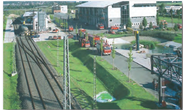
Abb. 16 Feuerwehr-Übungsanlage „Im Wendelrot“
