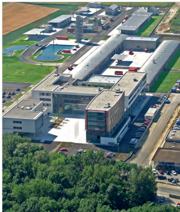
Abb. 11 Kompetenzzentrum, Tulln Langenlebarner Straße 106–108
