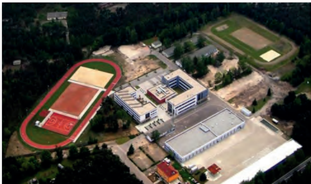
Abb. 15 Ansicht nach Abschluss des 2. Bauabschnitts
