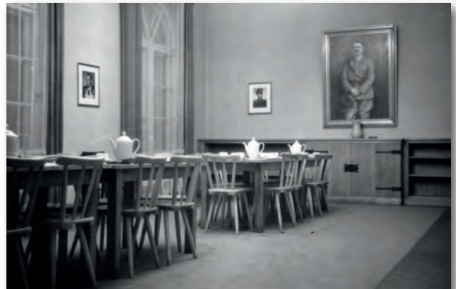
Abb. 10 Aufenthaltsraum / Frühstücksraum der Reichsfeuerwehrschule Eberswalde
