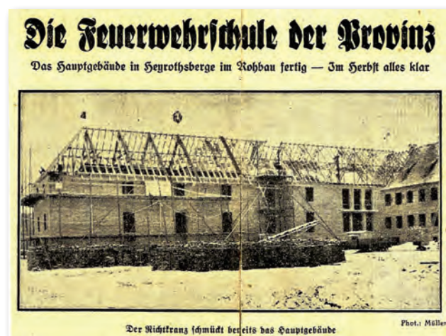
Abb. 3 Schulgebäude mit Richtkranz
