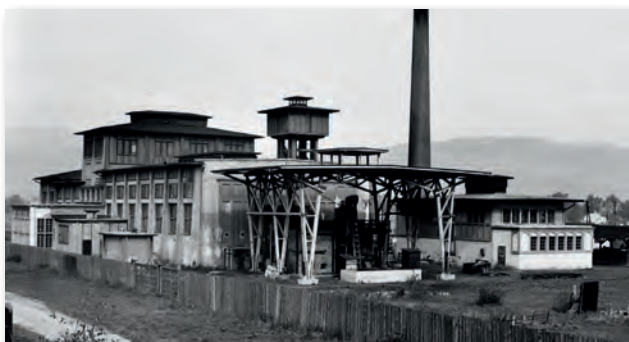
Abb. 1 die stillgelegte Permanganatfabrik vor dem Umbau
