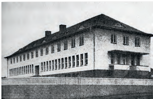
Abb. 20 Das 1936 eingeweihte Hauptgebäude der Provinzialfeuerweherschule Hessen-Nassau. (Foto aus: Die Feuerwehr. Festnummer anlässlich der Einweihung der Provinzialfeuerweherschule in Kassel, 15. November 1936, o.S.)
