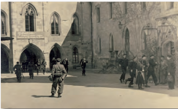
Abb. 13 Alarm an der Landesfeuerweherschule in Reinhardsbrunn 1952
