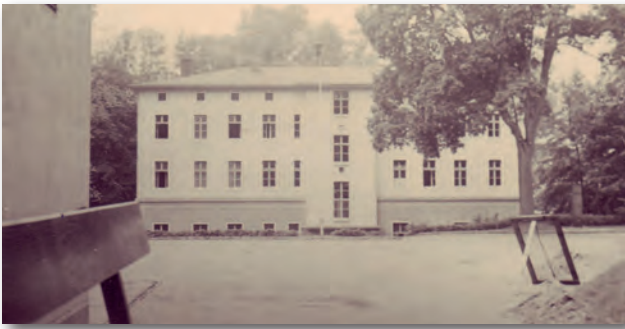
Abb. 5 Hauptgebäude der Reichsfeuerwehrschule Eberswalde, Blickrichtung vom Innenhof der Schule
