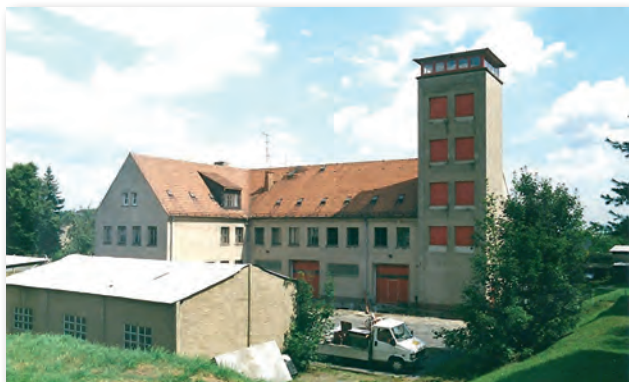
Abb. 17 ABK Kamenz Ansicht Hofseite Foto H.-D. Unkenstein
