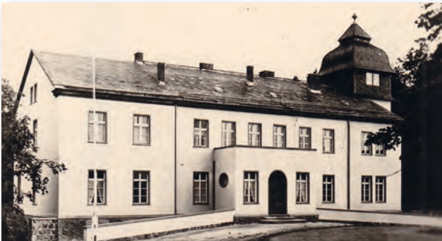
Abb. 1 Das Schulgebäude nach dem Umbau
