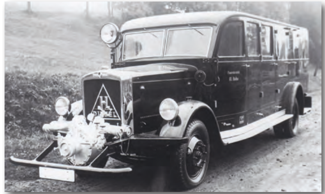
Abb. 3 Kraftspritze der Marke Flader auf Hansa-Lloyd Fahrgestell
