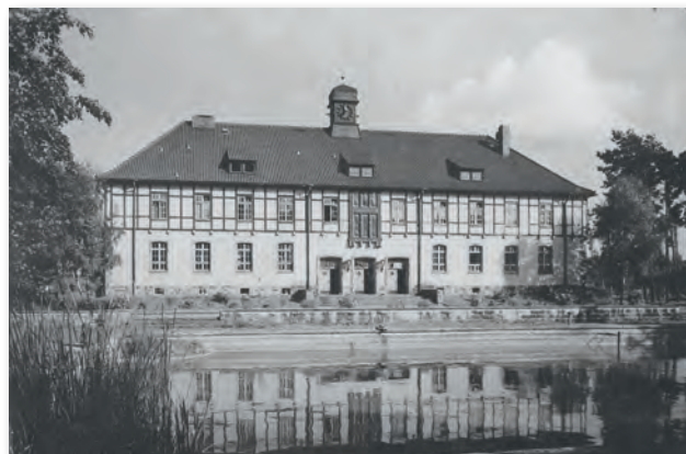
Abb. 14 Ein Gebäude der Landesfeuerweherschule Warendorf
