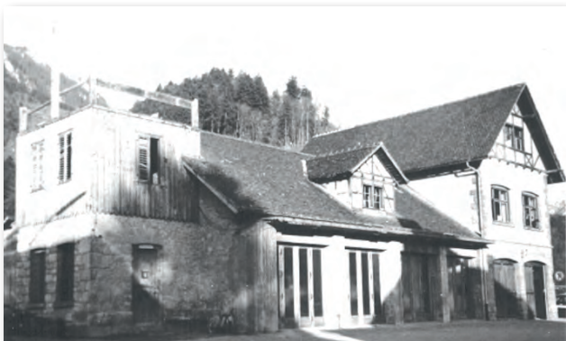
Abb. 10 & 11 Abbruch des ehemaligen Schlauchturmes und Aufbau eines neuen Stockwerkes für den Speisesaal 1962
