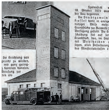
Abb. 19 Die Fahrzeughalle mit Steigerturm, 1937. (Foto aus: Die Feuerlöschpolizei 3 (November 1937), S. 89)
