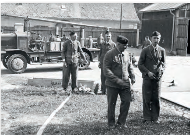
Abb. 15 Motorführerkurs 1942, Fotograf unbekannt; Archiv FF Bruck/Mur.
