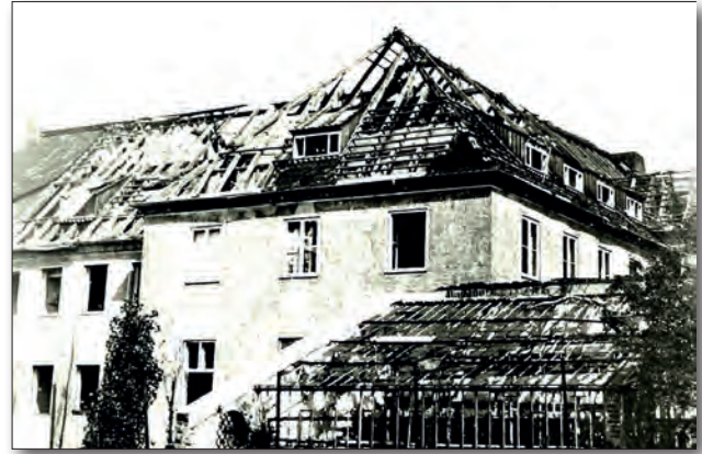
Abb. 6 Durch Bomben zerstörtes Schulgebäude
