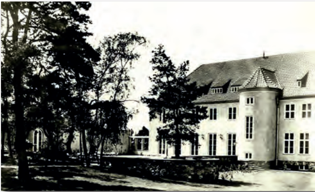
Abb. 7 Schulgebäude -Ansicht Hofseite
