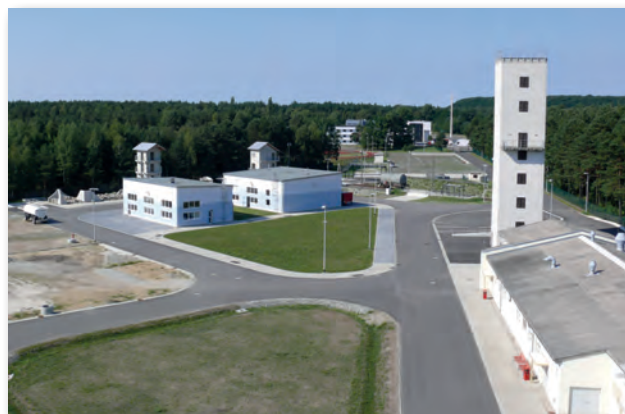
Abb. 20 Rechts Übungsturm und Atemschutzwerkstatt mit Atemschutzübungsstrecke
