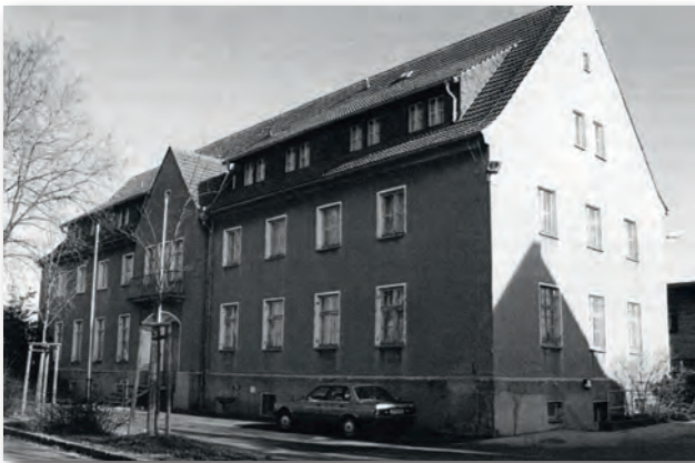
Abb. 5 Haus II in Hoyerswerda
