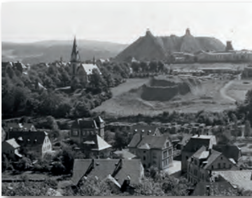
Abb. 1 Stadt der Halden und Schächte: Schlema in den fünfziger Jahren. (Archivfoto: Wismut GmbH)
