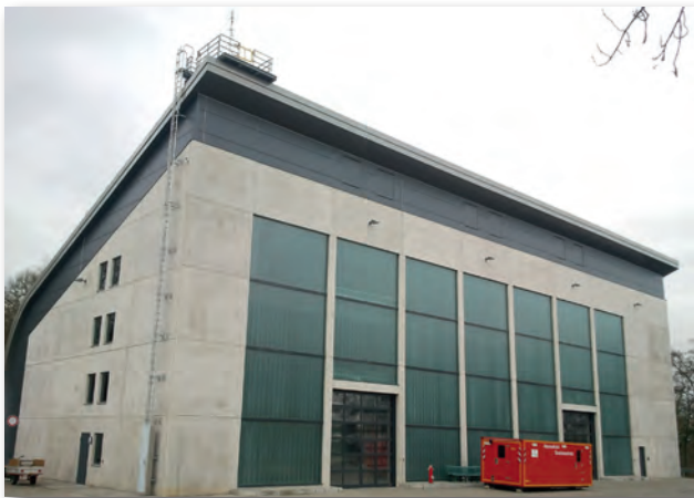
Abb. 2 Neue Übungshalle in Loy
