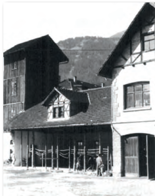
Abb. 8 Beginn der Umbauarbeiten am Gerätehaus Bludenz 1957
