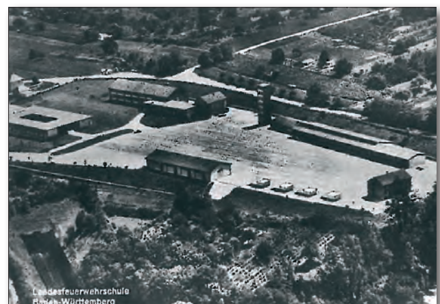
Abb. 13 Die neue Landesfeuerweherschule in der Steinackerstraße
