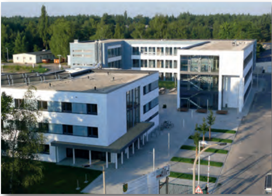
Abb. 21 Internat und Lehrsaal- und Verwaltungsgebäude
