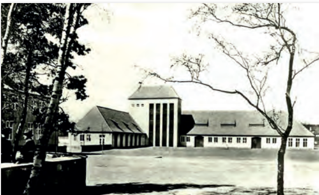
Abb. 8 Übungshalle mit Steigerturm und Turnhalle
