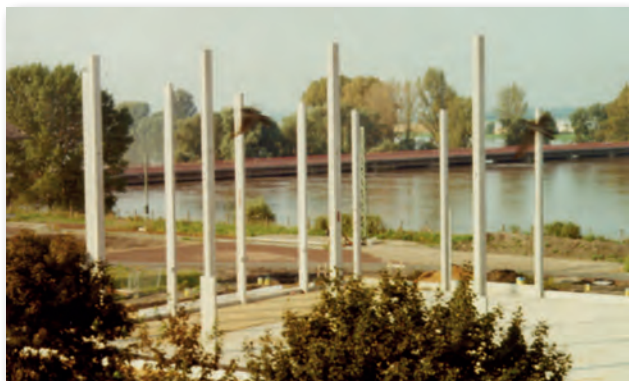
Abb. 22 Hochwasser 2002 (i. Bi. Elbumflutkanal, vorn Baustelle AÜG)
