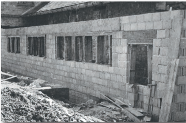
Abb. 9 Anbau der Schlauchwäscherei 1957
