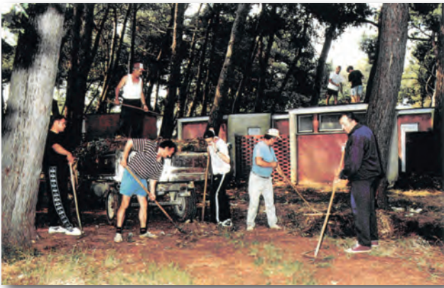
Abb. 6 Säuberungs- und Flächengestaltungsarbeiten in Fažana
