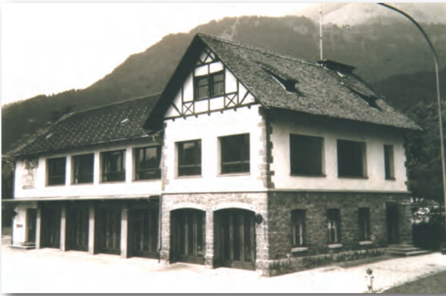
Abb. 12 Die Landesfeuerwehrschule Vorarlberg im 1. OG des Gerätehauses der Feuerwehr Bludenz (rechts der Stiegenaufgang, über den zwei rechten Garagen der Lehrsaal, links davon der Speisesaal mit Garderobe, im hinteren Teil Küche, Lehrmittelraum und Bekleidungskammer)
