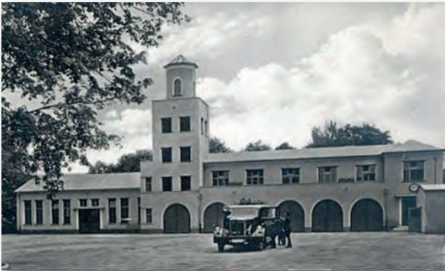
Abb. 7 Niederschlesische Feuerwehrschule Waldenburg
