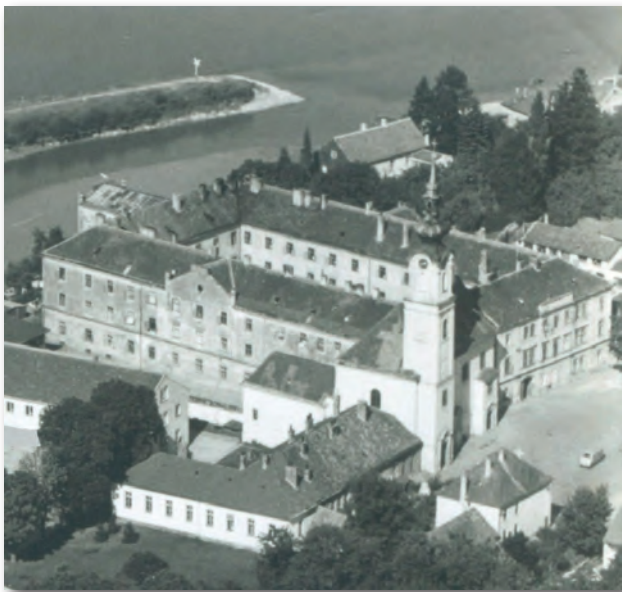
Abb. 4 NÖ Landes-Feuerweherschule Tulln, Albrechtsgasse 36, im Vordergrund Stöckelgebäude, Minoritenkirche und Kaserne
