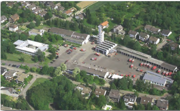
Abb. 15 Landesfeuerwehrschule in der Steinackerstraße
