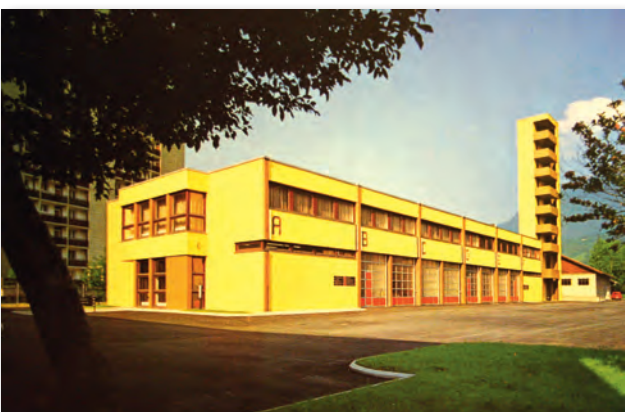
Abb. 10 Erweiterung der Schule 1979
